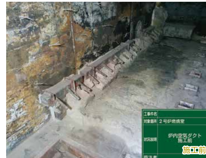
焼却炉内空気ノズル 補修工事
