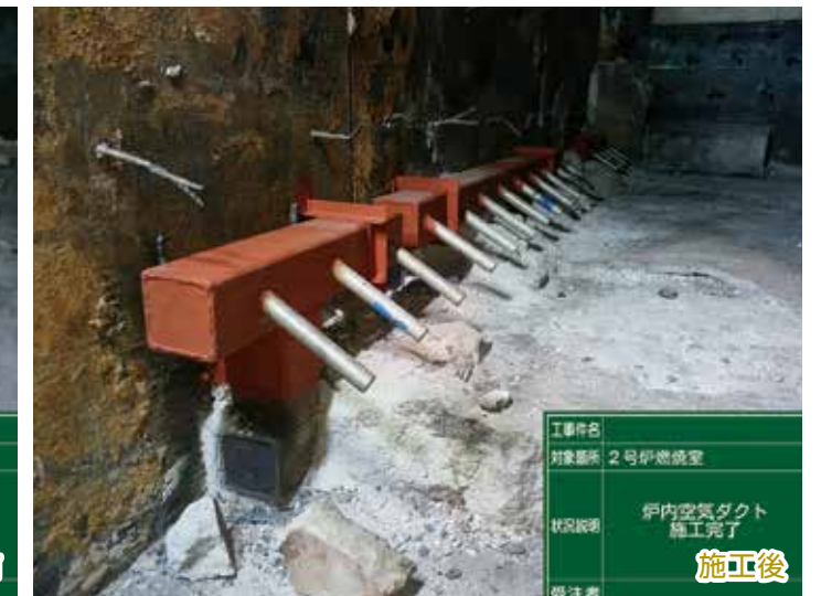
焼却炉内空気ノズル 補修工事
