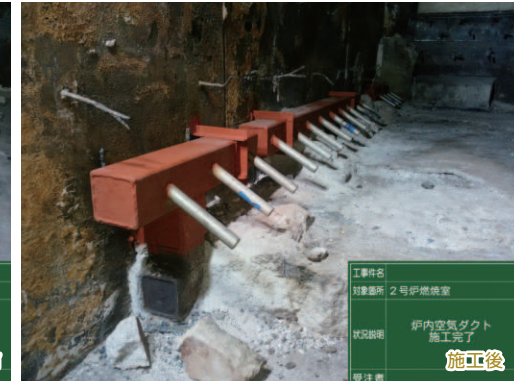
焼却炉内空気ノズル 補修工事
