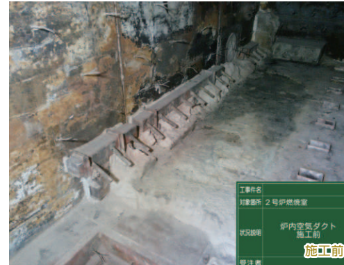
焼却炉内空気ノズル 補修工事
